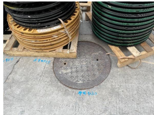
项目污水井盖
