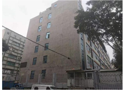
项目东北面工业厂房
