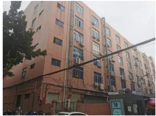
项目东南面工业厂房
