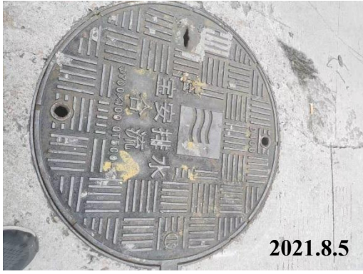
项目所在地污水井盖
