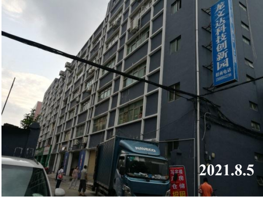
项目厂房外观
