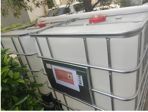
清洗废水收集装置
